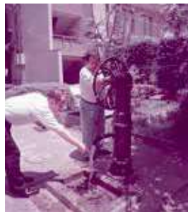
手廻しポンプ(雨水を利用)
