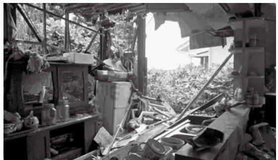
鴨川市海岸部の倒壊した住宅内の様子
